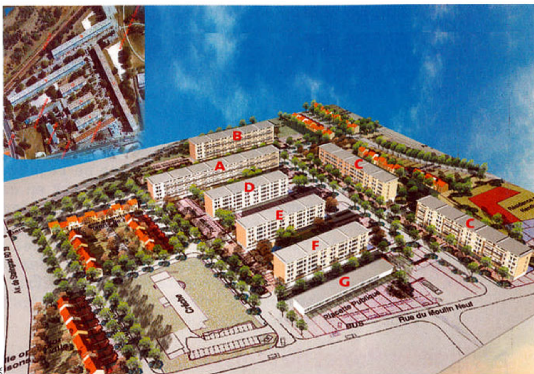
La cité du Moulin-Neuf au terme du projet et, en incrustation, une vue aérienne prise en 2000. Les quatre plus grandes barres sont partiellement démolies ou coupées: la B a été démolie à ses deux extrémités comme la G; la moitié de la barre A a été détruite. Il reste à couper la C (photo ci-dessous) dans sa partie centrale et à l'une de ses extrémités (côté barre B). Le foncier ainsi libéré permet la création de nouveaux espaces publics, la mise en place d'une trame viaire et la construction de 80 pavillons et maisons de ville: 60 par 3F, à proximité de la crèche, et 20 par la « Foncière », en bordure du parc de la Courneuve.
