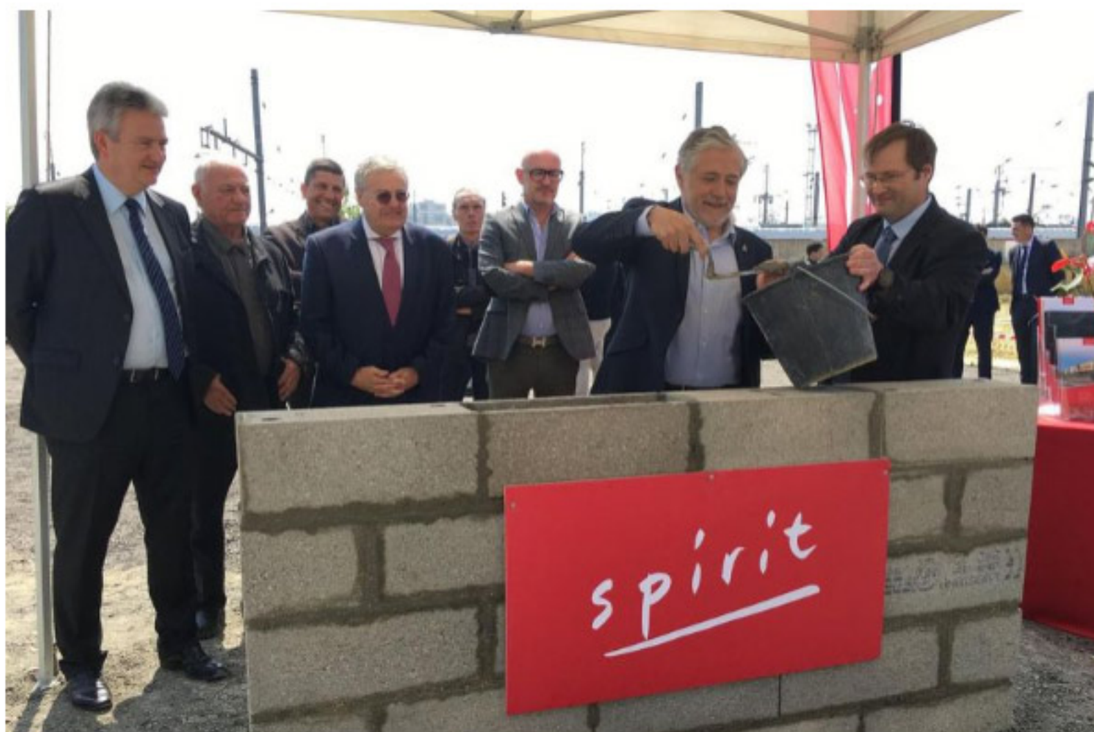
Noisy-le-Sec, le 16 mai. Laurent Rivoire, maire de Noisy-le-Sec, truelle en main, participe au dépôt de la première pierre du Parc Spirit du Canal de l'Ourcq
