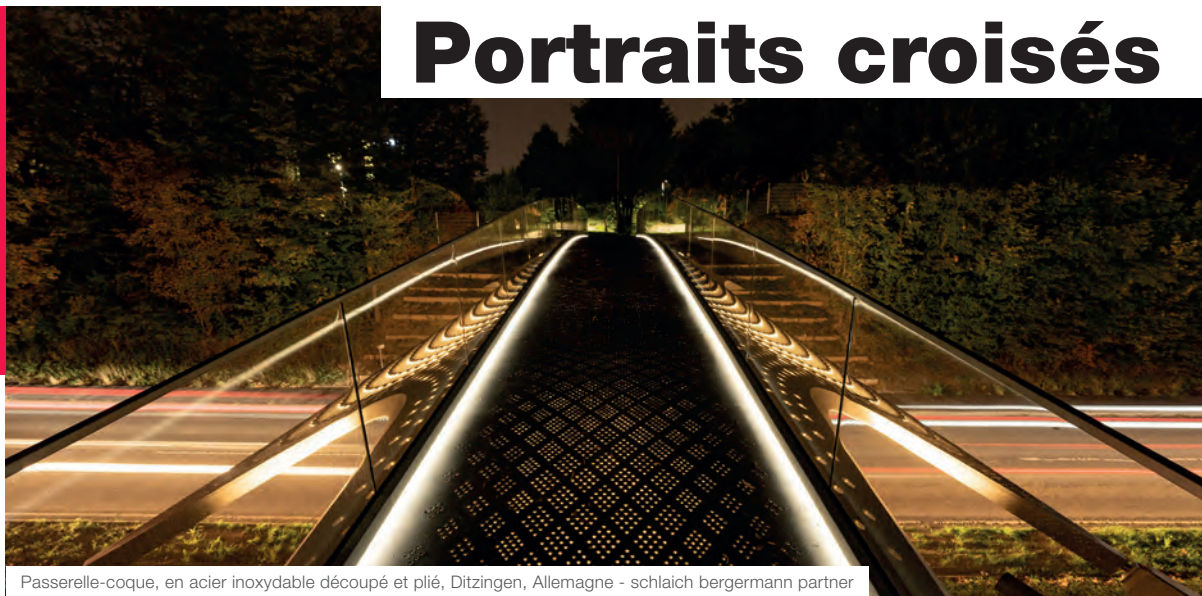
Passerelle-coque, en acier inoxydable découpé et plié, Ditzingen, Allemagne - schlaich bergemann partner
