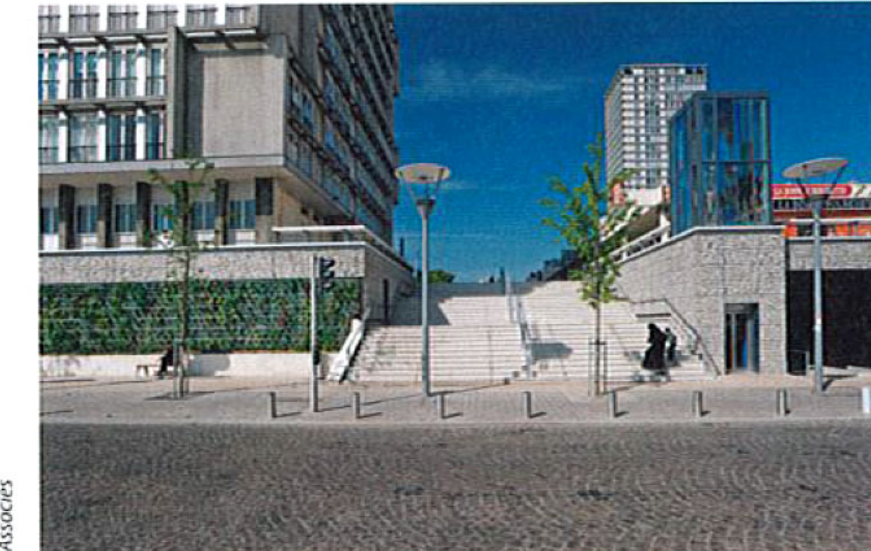
Photo 10. Nouvel accès à la dalle Sud et aux parkings en ouvrage
