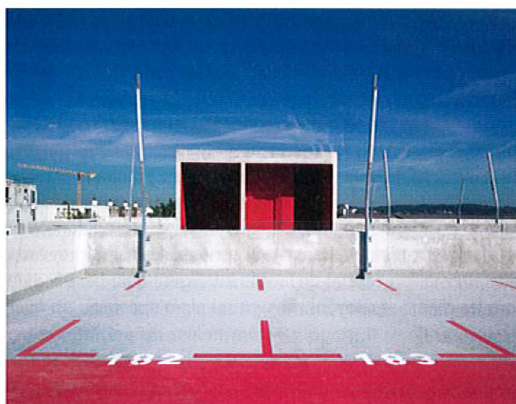
Photo 1. Parkings mutualisés à l'échelle d'un îlot, Bègles (33)
