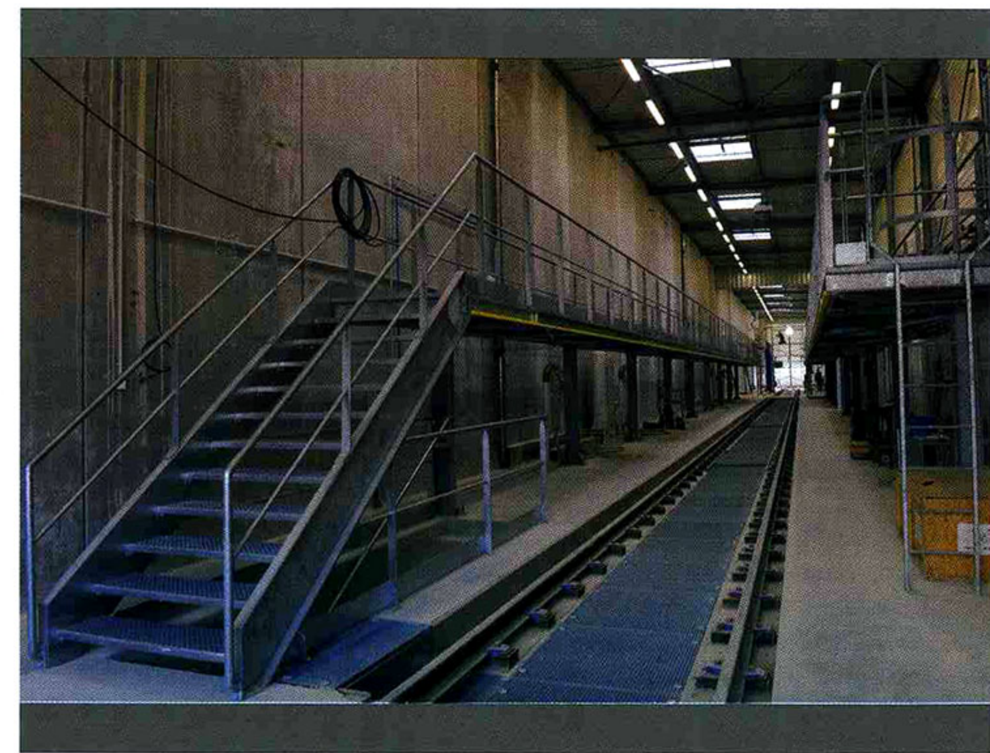
Chaque soir, passage obligé par la station service pour y subir l'entretien courant comme le remplissage des réservoirs de sable.
