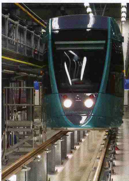
Idéale pour la maintenance : l'une des deux voies en fosse avec rails sur pilotis et passerelles d'accès aux toitures.
