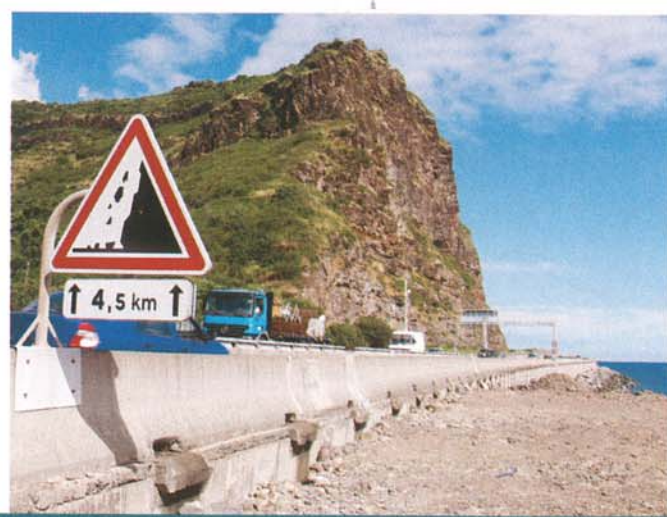
Malgré les lourdes protections ancrées sur la falaise, la RN1 est perpétuellement menacée par les éboulements.
