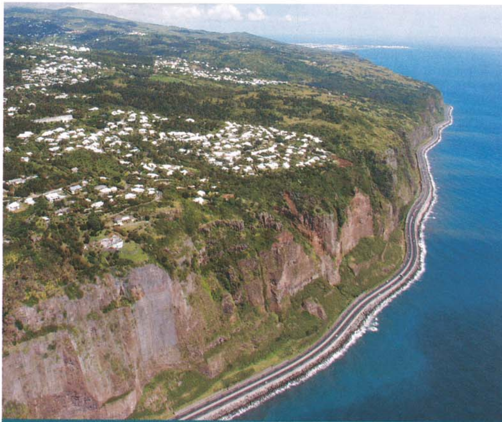
L'érosion rend la route du littoral particulièrement dangereuse.
