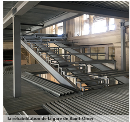
la réhabilitation de la gare de Saint-Omer
