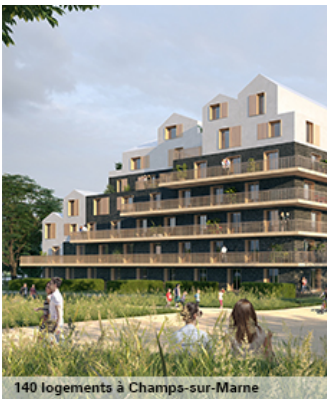
140 logements à Champs-sur-Marne
