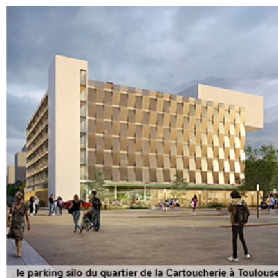
le parking silo du quartier de la Cartoucherie à Toulouse
