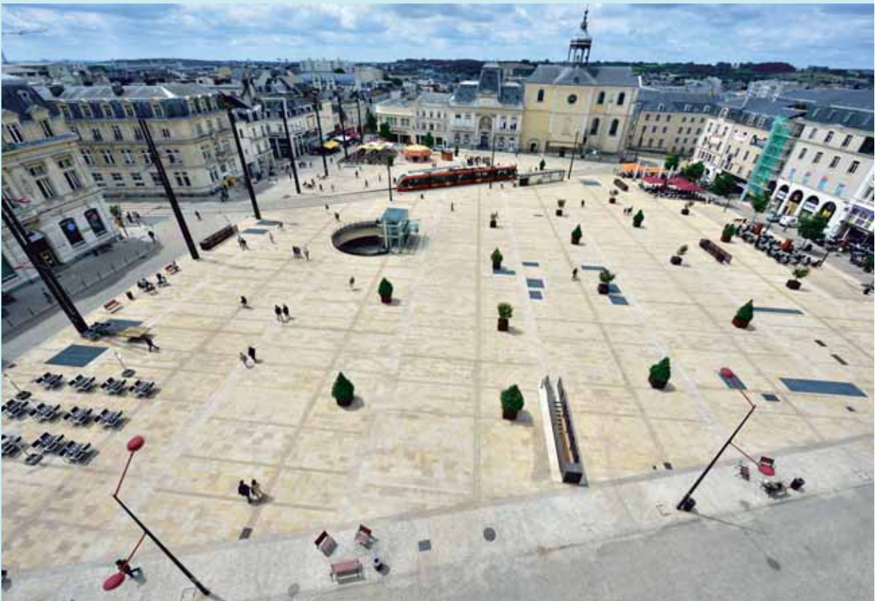
La place de la République complètement piétonnisée Le Mans, 2007 ©Richez_Associés
